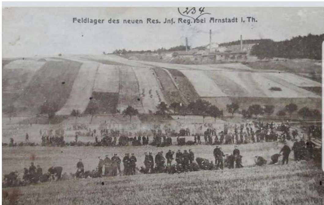
Die Tonwerke am Kirchberg. Postkarte von 1914 anlässlich eines Mannövers Der in Arnstadt stationierten Infanterieregiments. Das Feldlager befand sich auf dem heutigen Gelände des Kieswerkes.
