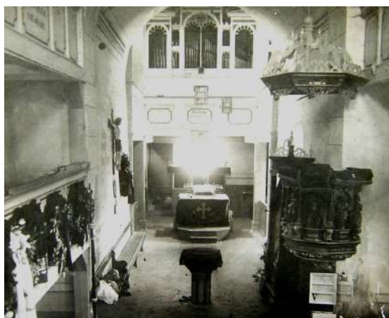
Ansicht des Kirchenraumes von 1906: Komplette Kanzel mit Schalldeckel und Tür am Aufgang
